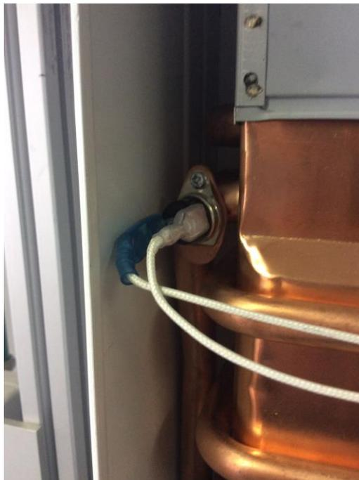
Figura 15 – Limitador de temperatura – activación a 85°C
