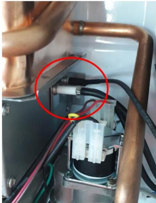
Figura 12 – Electrodo de ignición
